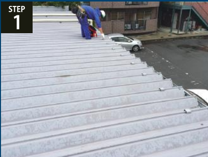
棟用金具配置→仮留
