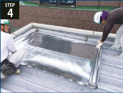
サーモバリア（遮熱シート）張り
