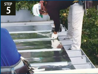
遮熱シート押え取付
