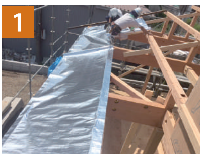
母屋の上にサーモバリアエアーを取付
