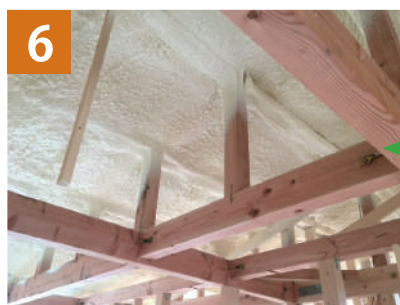
母屋の上にサーモバリアエアーを敷き、タルキを取付け通気層を確保し、 発泡ウレタンをサーモバリアエアーに吹付けます。
