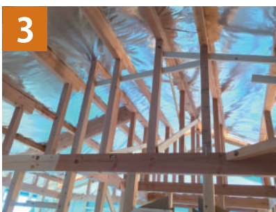
屋根の下から見た状態
