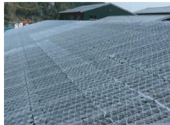
1 安全ネットを取付け
