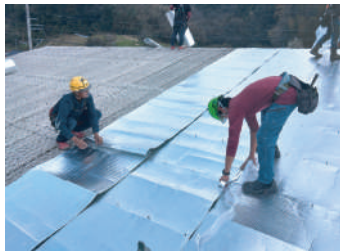
2 サーモバリア施工
