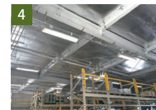
4 シートのジョイントを専用アルミテープで繋ぎ止めて完成です。
