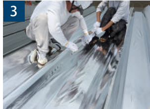
3 シートとシートの合わせ目を両面テープで密着させます。
