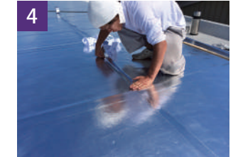
4 シートのジョイントと端部を専用ガラスクロスアルミテープで貼り合わせます。
