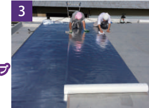
3 貼付け後、上から良く抑えて接着面と密着させます。
