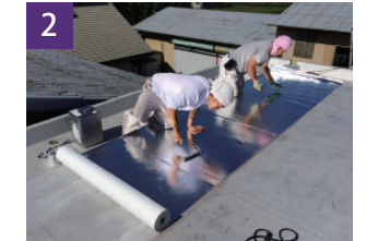
2 接着剤の上からサーモバリア・トップを転がし貼付けます。
