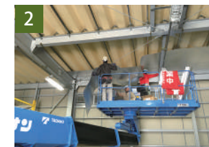
2 取付下地(軽量鉄骨材)は約1mの間隔で設置します。
