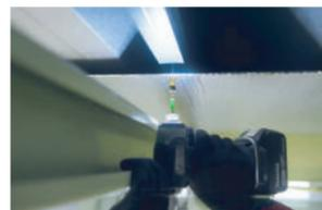
5 サーマバリアを下地鋼材にタッピングビスで取り付け
