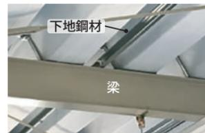
2 下地鋼材を約1mピッチに取り付けます
